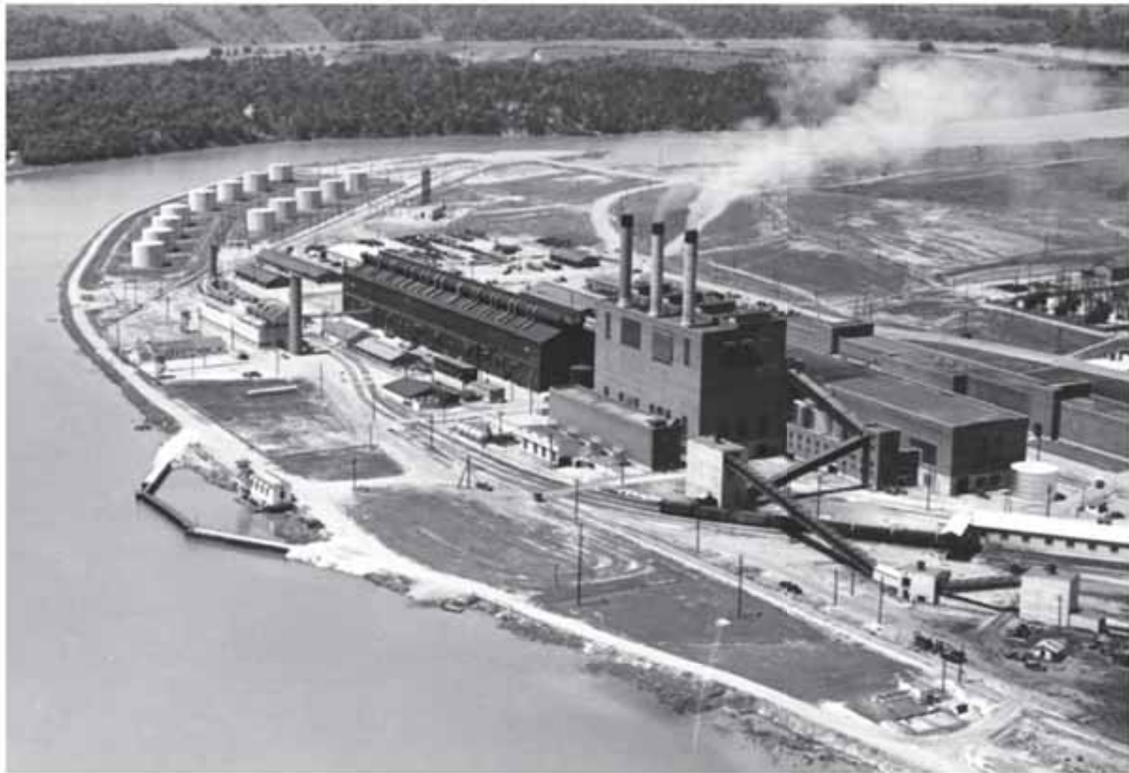
Planta de separació d'isòtops Oak Ridge, Tennessee US Department of Energy Ed Wescott
